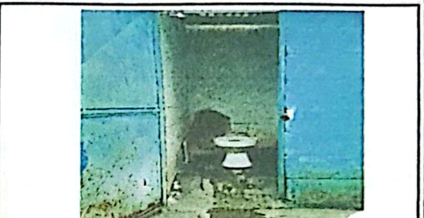
Sustitucion de 3 Inodoros por estar en mal estado
