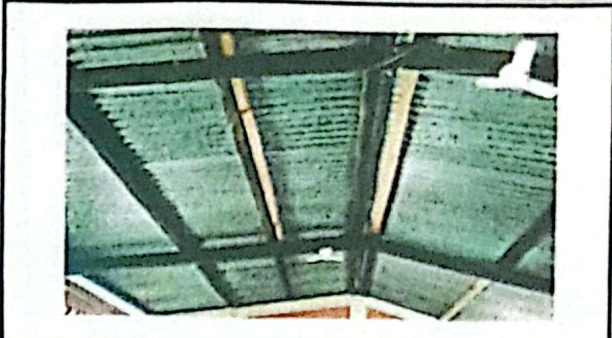
Foto 2: Sustitución de soporte de madera por metal de las Aulas 1, 2 y 3= 120 mts. por que la madera ya nom esta en condición unos ya estan quebradas
